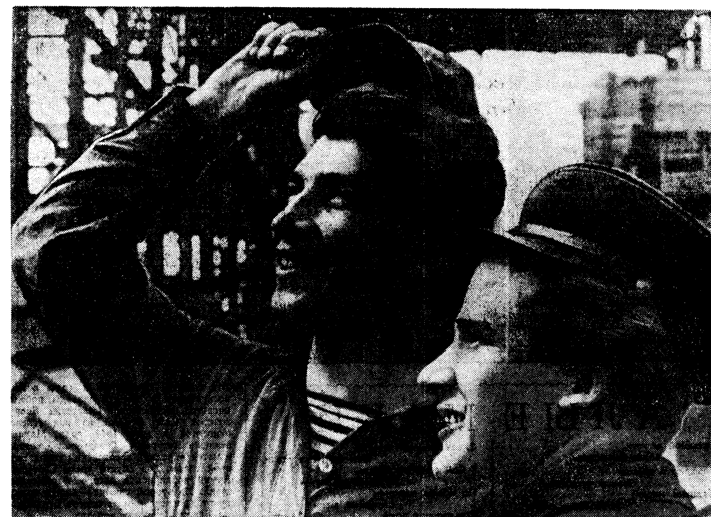
Недалеко от Кривого Рога строится гигант горнорудной промышленности — Центральный горнообогатительный комбинат. Здесь много вчерашних воинов. Крепко подружились бывший моряк Николай Байбарак и артиллерист Николай Борисюк. Оба они — передовые бетонщики. Бригада, в которой работают демобилизованные воины, борется за почетное звание коммунистической. На снимке: Николай Байбарак (слева) и Николай Борисюк. Фото А. Афанасьева.
